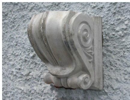
Architektonický doplněk: voluta z geopolymery
